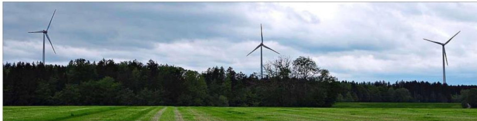
Etwa 1200 Meter Luftlinie von den drei der vier Anlagen des Windparks Wadlhauser Gräben entfernt war der Startpunkt der Exkursion. 2015 wurden sie errichtet. Sie haben eine Nabenhöhe von 149,0 Metern, einen Rotordurchmesser von 115,71 Metern, sind also niedriger als die im hiesigen Staatsforst vorgesehenen.
